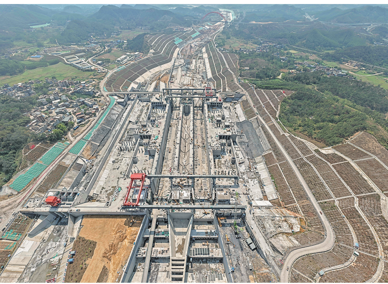
这是2026年3月5日拍摄的广西平陆运河马道枢纽建设现场(无人机照片)。 新华社记者 周华摄
