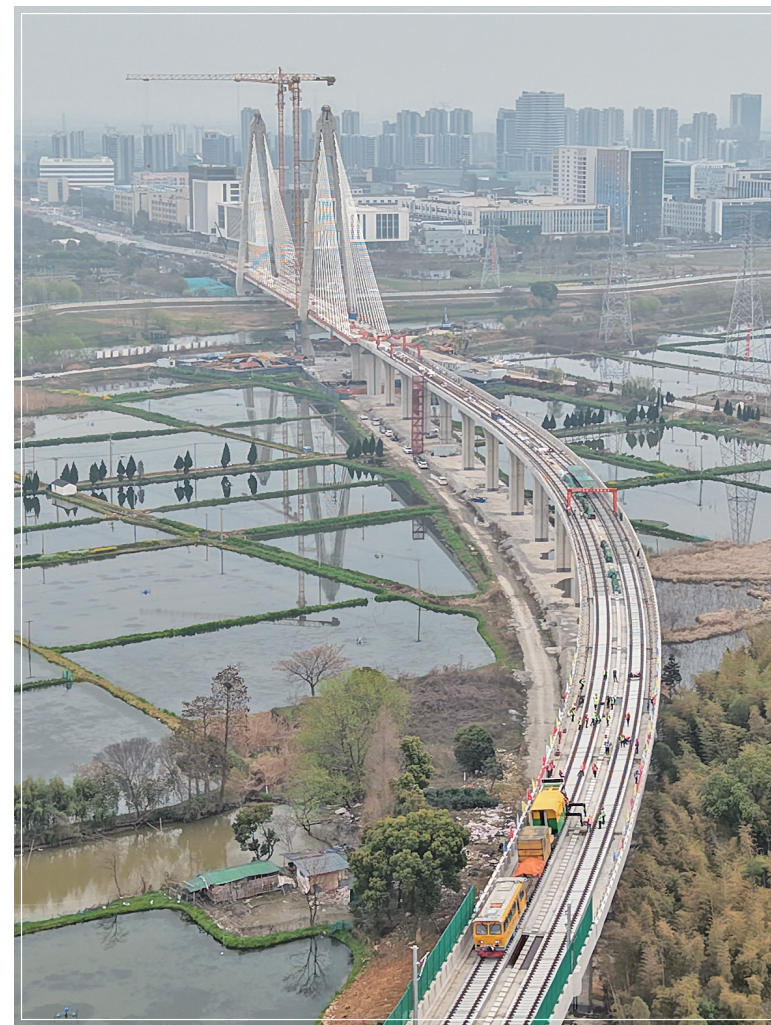
▲3月22日拍摄的杭州至德清市域铁路施工现场（无人机照片）。当日，在杭州至德清市域铁路施工现场，一款新能源多场景闪光焊机首次在钢轨上开展焊接作业。该设备采取了混合动力模式，搭载智能能源管理系统，支持“边充边焊”模式，在满电状态下可独立完成50个钢轨接头焊接，保障无外接电源区域连续稳定施工。此款智能装备可应用于本线、邻线、线下、道岔等各类场景，具备“一机多场景、一机多功能”的优势。 新华社记者 黄宗治 摄
