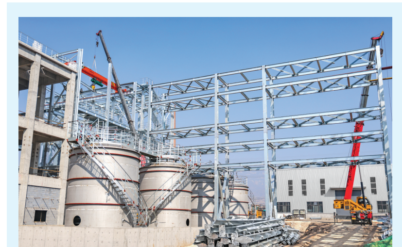
眼下，位于稷山县的山西永东化工股份有限公司2×10万吨/年萘油深加工项目正加紧建设中。该项目建成投产后，可充分满足企业中高端炭黑生产中关键原材料的自我供给，将特种炭黑产业链进一步向前端延伸，实现能源的综合利用。 本报记者 常奇 摄
