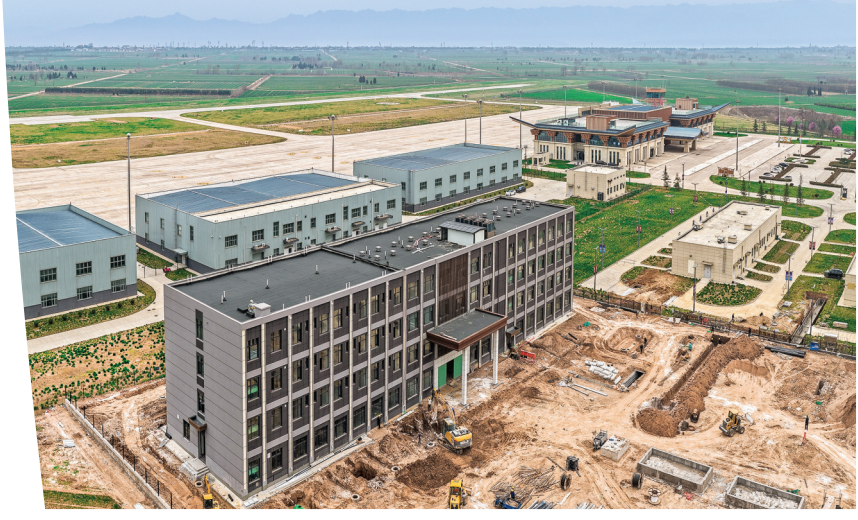
芮城通用机场改扩建项目
