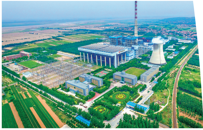
陕煤电力运城有限公司火储联合调峰调频项目
