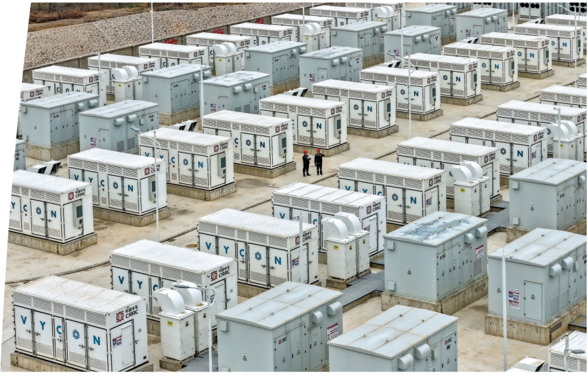
中能国域能源科技有限公司100MW/50.41MWH独立储能建设项目
