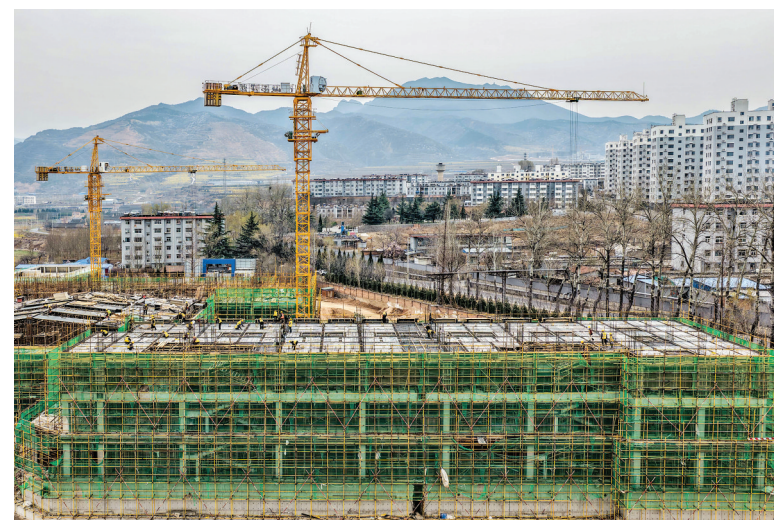
▲3月26日拍摄的绛县养老服务中心项目施工现场。该项目规划床位359张,总建筑面积16890.07平方米,紧扣“设施齐全、环境舒适、宜居宜养”目标,致力于打造现代化养老机构,助推区域养老事业高质量发展。本报记者 金玉敏 摄
