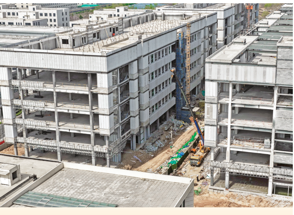
▲山西英飞拓动力科技有限公司二期项目建设现场,工人们加速施工。本栏照片均由本报记者 金玉敏 摄
