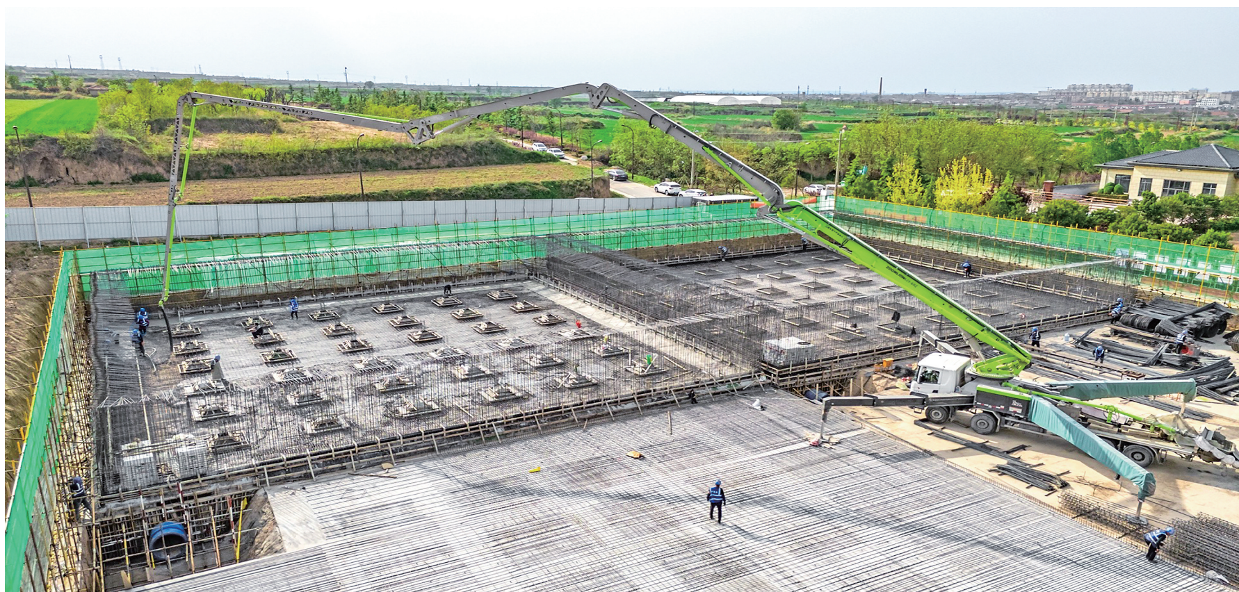
▲4月16日,在万荣县城乡供水一体化工程(城南供水站)建设现场,工人在抓紧建设提水泵站。
