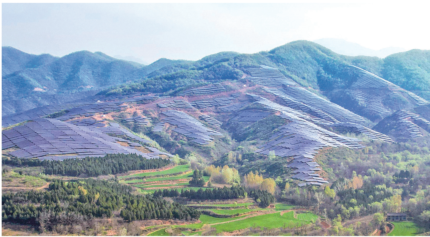
▲这是4月22日拍摄的垣曲县皋落乡东山村山坡上的光伏发电基地。近年来，垣曲县依托丰富的风能、太阳能和水能资源，大力发展风电、光伏发电、抽水蓄能等新能源，着力打造全国知名的新能源产业基地。
