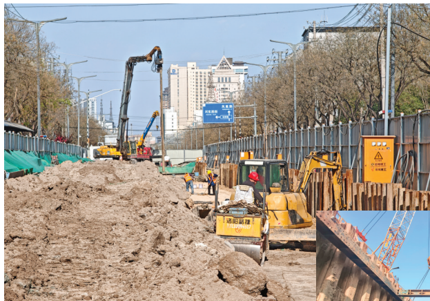
▲基坑土方回填和钢板桩拆除
